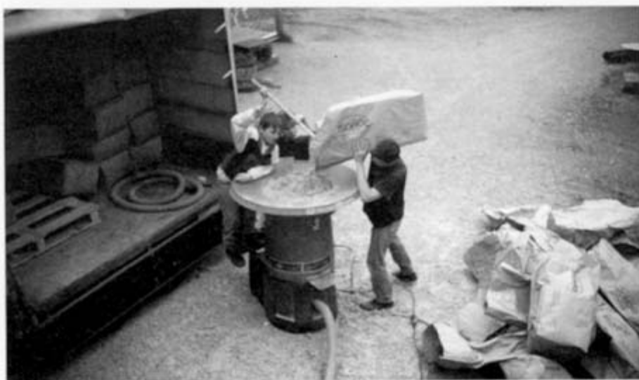
Das ökologische Dämmmaterial wird ins wiederaufgebaute Nurdachhaus eingeblassen
