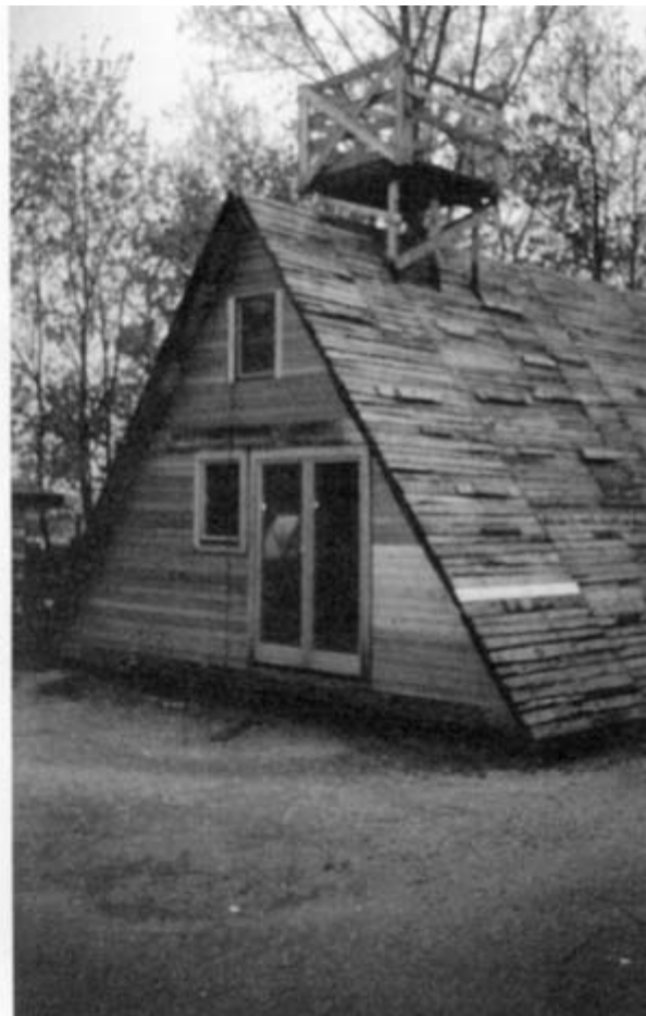
Das Nurdachhaus steht - vieles kann noch ausgebaut werden
