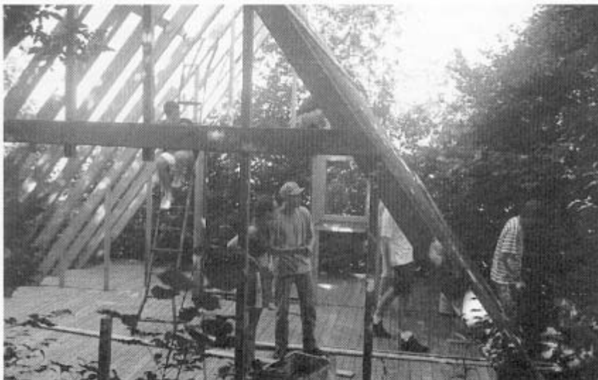
Das Nurdachhaus vom Gardasee wird zerlegt
